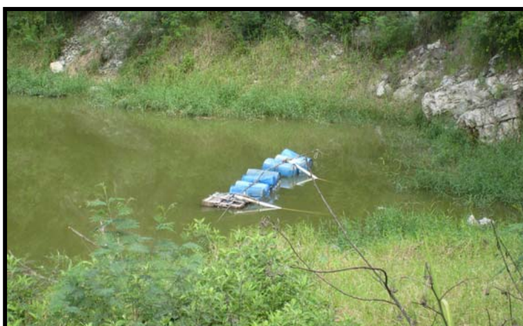
Figuras 2 e 3 - Instalações da Cooperágua.
