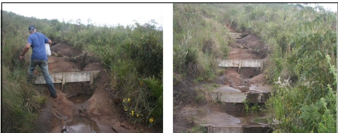
Figura 25 - Tábuas colocadas na trilha para contenção da erosão: área com declive acentuado, propícia a alagamentos. Fonte: a autora, 2009
