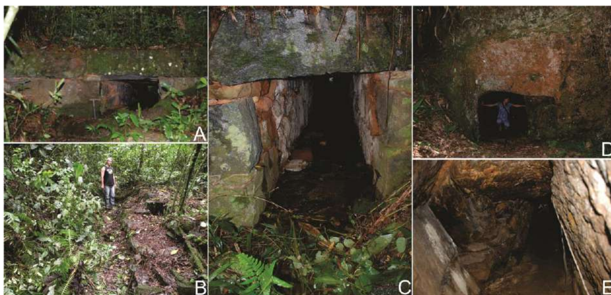
Figura 1 – Aspectos dos dutos e túnel: entrada a jusante (A) e aspectos exterior (B) e interior (C) de dutos; entrada a jusante (D) e aspecto interior (E) do túnel.
