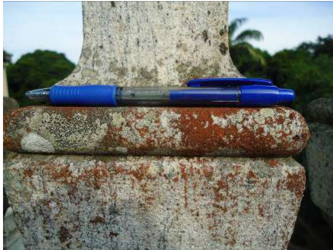
Figura 2: Balaústre com colonização biológica.
