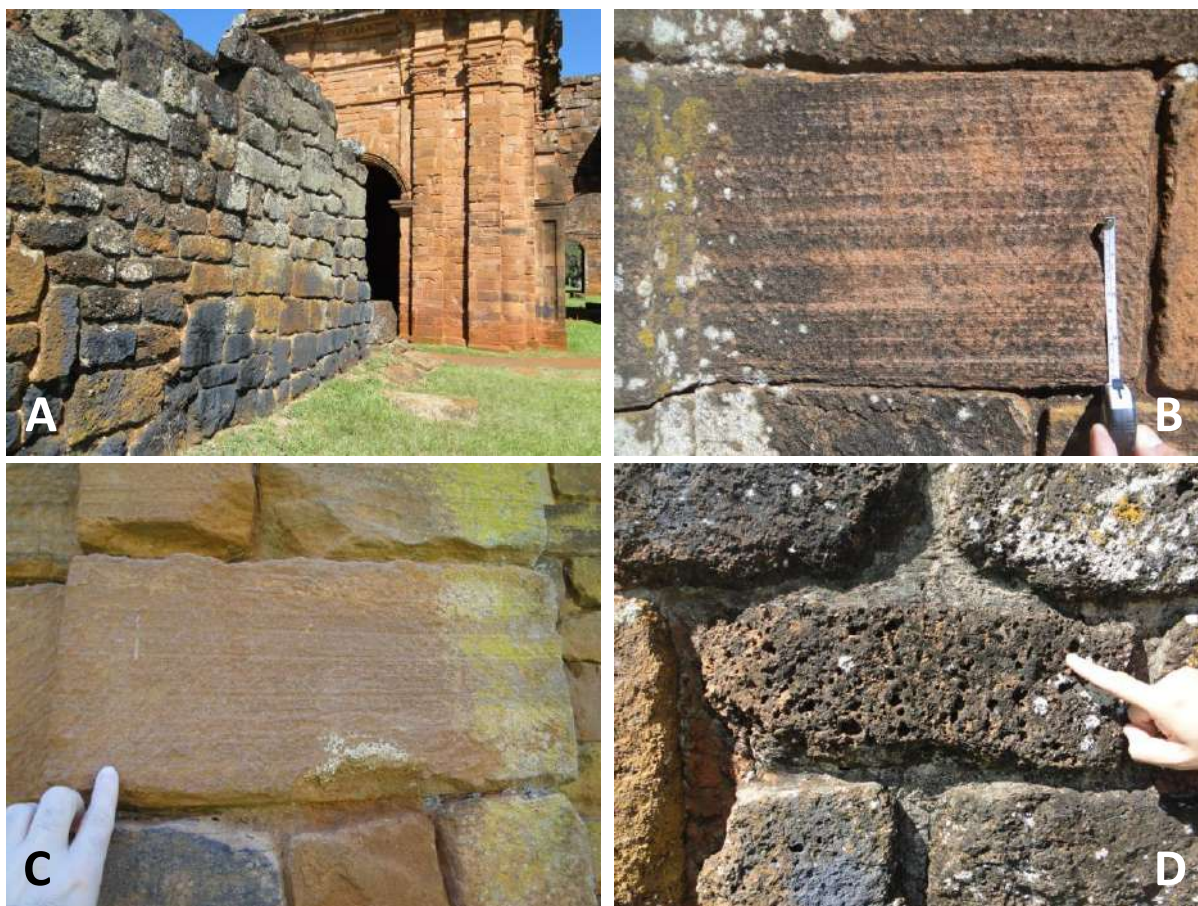
Figura 2 – Aspectos dos blocos construtivos analisados: (A) parte lateral do sítio histórico de São Miguel das Missões, construída tanto com blocos de arenito avermelhado (porções mais nobres, como a igreja) quanto com blocos de basalto/brecha basáltica escuro (muros); (B, C) blocos de arenito com linhas/planos correspondentes a estratificações cruzadas; (D) blocos de basalto brechado e vesicular do muro representado em A.
