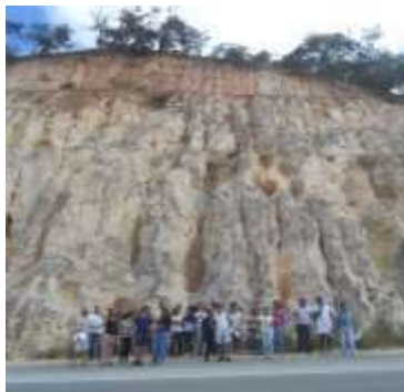
Figura 2- Embasamento cristalino alterado. Jun/2014.
